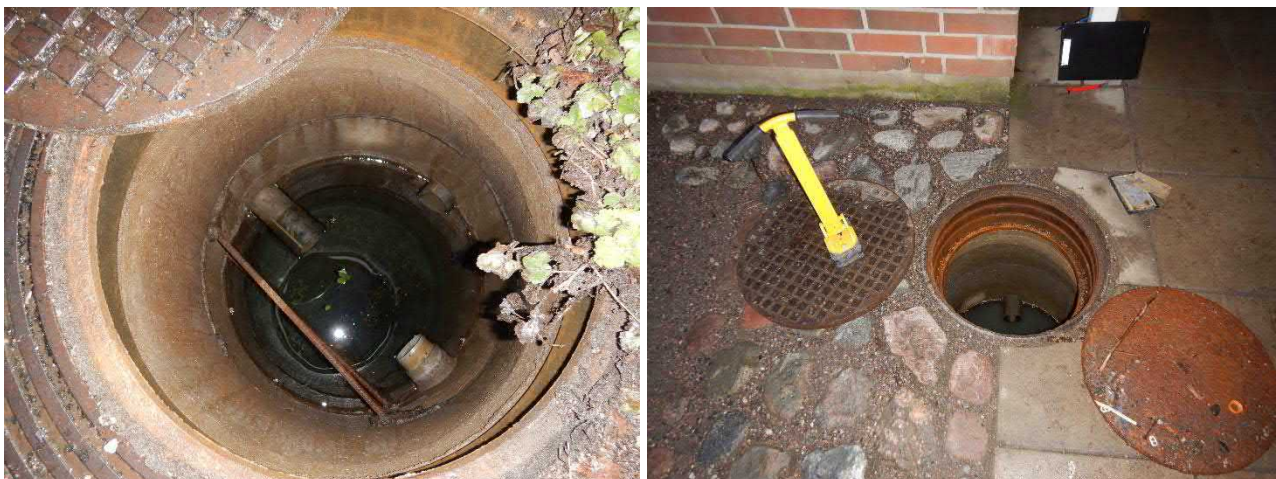
Kuva 15. Tarkastuskaivojen vedenpinta salaojaputkien alapinnan tasolla.
