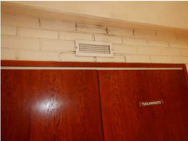
Kuva 111 Liikuntahallin tuolivarastonoven yläpuolella tuloilmapäätelaite, jota ei ole esitetty suunnitelmissa. Ennen päätelaitetta äänenvaimennin ja kanavapuhallin. Kanava tuotu läpi alapohjasta.
