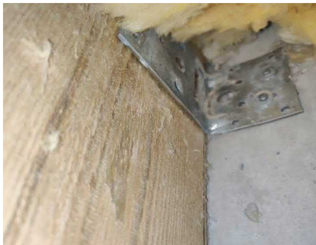
Kuva 60. Pystykarmiin tehdystä avauksesta havaittiin, että apukarmi on kiinnitetty kulmarauodoilla takana olevaan pilariin. Ei vesijälkiä.
