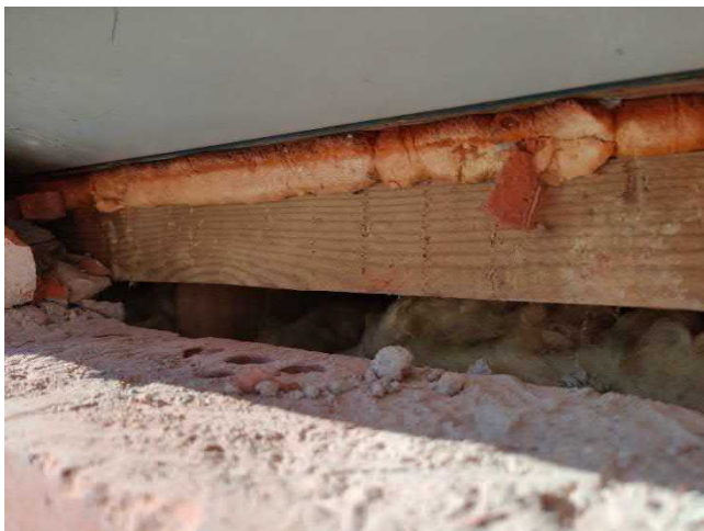
Kuva 65. Rakenneavauksen I8 ikkunan alapuoleinen avaus. Ei vesijälkiä tai tummumaa.
