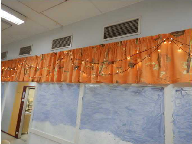
Kuva 99 Poistoilmasäleikköjen pinnoilla selvää pölykertymää, ja säleiköt selkeästi tuloilmasäleikköjä likaisempia. Tasauslaatikon pinnoilla niukalti tiukasti tarttunutta pölyä.
