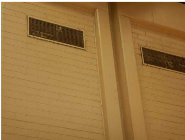
Kuva 101 Alkuperäisen osan ilmanjako on toteutettu tulo- ja poistoilmasäleiköillä. Liikuntasalin poistoilmasäleiköt selkeästi likaantuneet.
