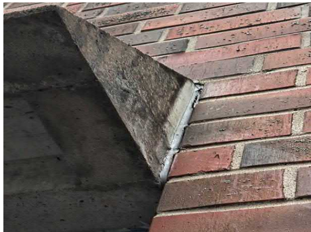
Kuva 86. Betoniräystäissä todettiin runsaasti kosteusrasituksen aiheuttamia jälkiä sekä epätiivittä elementtisaumauksia. Räystäspellitykset on uusittu lähiaikoina.
