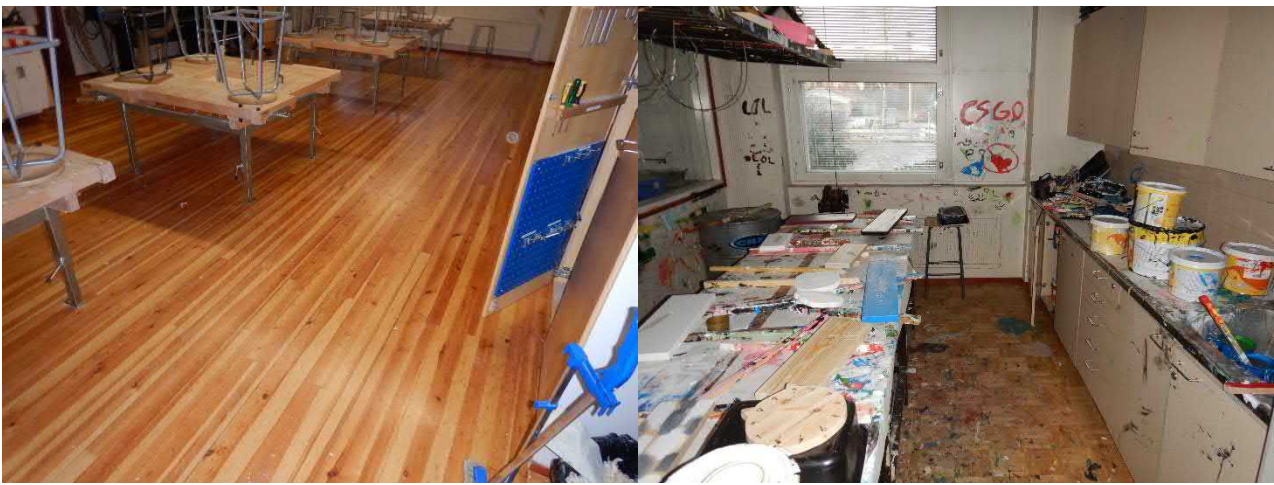
Kuva 90 Puutyösalissa lattiapinnoite on uusittu ja maalaustilassa vanha parketti.
