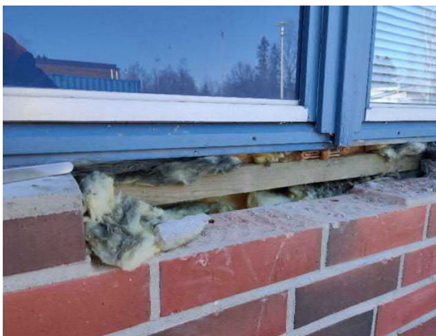
Kuva 55. Rakenneavaus I9 ikkunan alapuolelle. Ei vesijälkiä apukarmissa.
