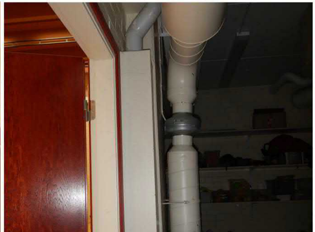
Kuva 111 Liikuntahallin tuolivarastonoven yläpuolella tuloilmapäätelaite, jota ei ole esitetty suunnitelmissa. Ennen päätelaitetta äänenvaimennin ja kanavapuhallin. Kanava tuotu läpi alapohjasta.
