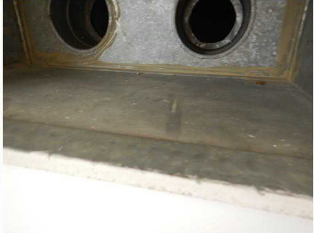
Kuva 99 Poistoilmasäleikköjen pinnoilla selvää pölykertymää, ja säleiköt selkeästi tuloilmasäleikköjä likaisempia. Tasauslaatikon pinnoilla niukalti tiukasti tarttunutta pölyä.
