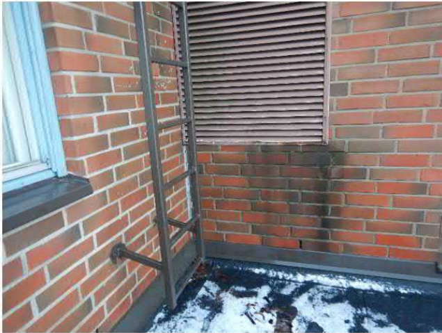
Kuva 110 Ulkoilmasäleikön alapuolinen tiilipinta selvästi kastunut useasti. Myös koneen sisäpuolisissa osissa selviä merkkejä veden pääsystä koneen sisäosiin.
