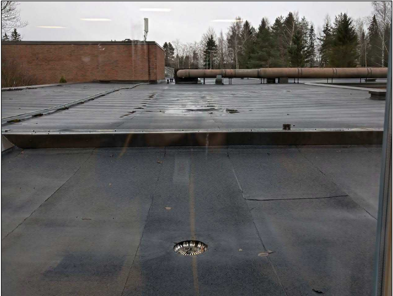
Kuva 80. Vesikate on uusittu lähiaikoina.
