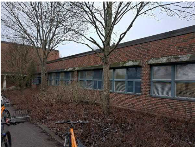
Kuva 86. Betoniräystäissä todettiin runsaasti kosteusrasituksen aiheuttamia jälkiä sekä epätiivittä elementtisaumauksia. Räystäspellitykset on uusittu lähiaikoina.
