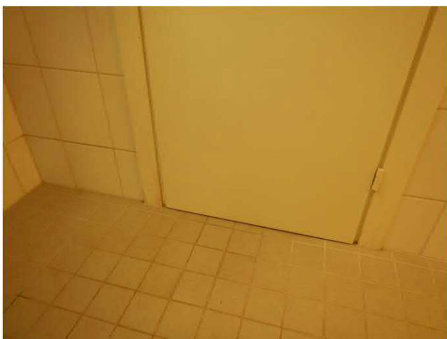
Kuva 102 WC-tilojen kohdepoistojen vaatimat oviraot pääosin kunnossa, mutta osassa tiloista oviraot eivät täyttäneet wc-tilojen oviraolle suositeltua 10 mm:n korkeutta.
