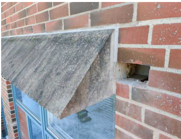
Kuva 57. Rakenneavaus I9 ikkunan yläkulmaan.
