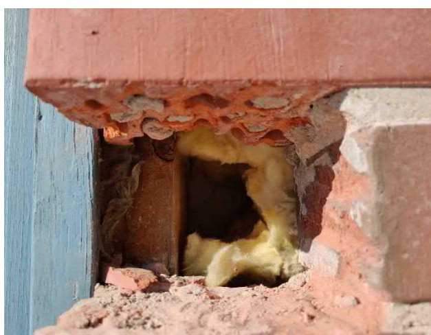
Kuva 64. Rakenneavauksen 18 pystykarmin avaus
