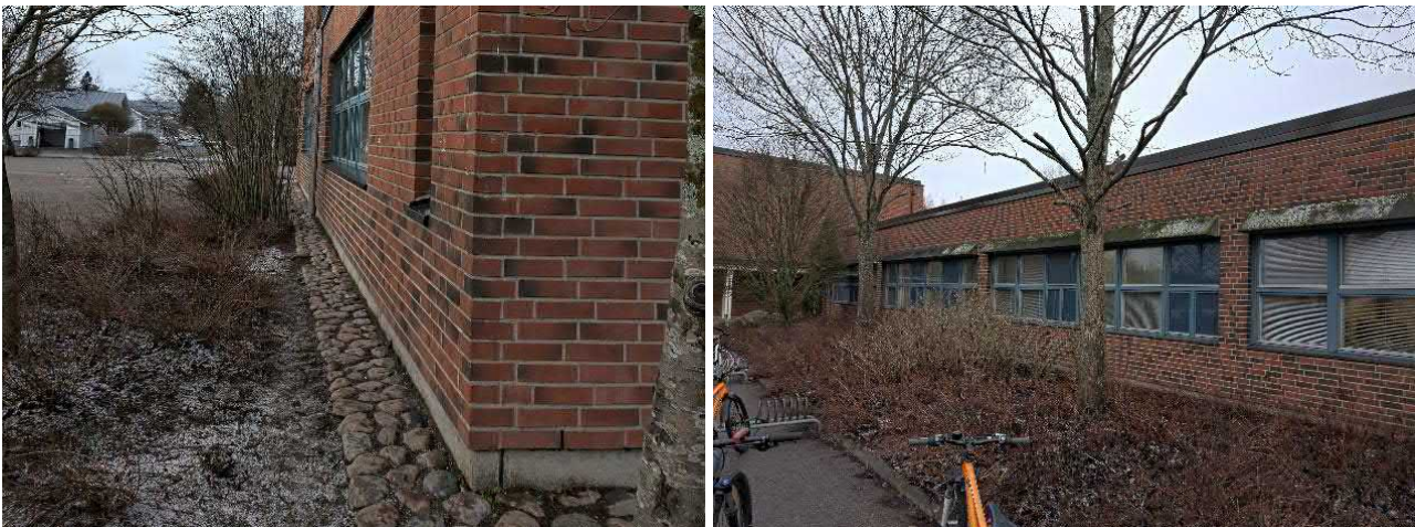
Kuva 4. Rakennuksen vierustaa kiertää kiviladonta. Rakennuksen kiviladonnan ja asvaltoinnin välissä on istutusalueita.
