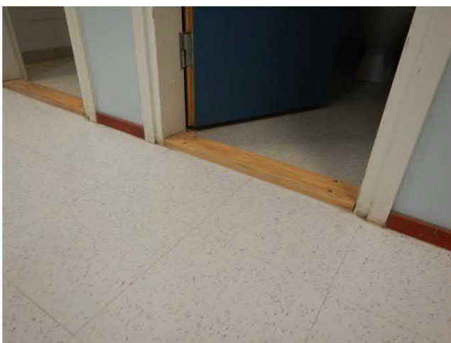
Kuva 102 WC-tilojen kohdepoistojen vaatimat oviraot pääosin kunnossa, mutta osassa tiloista oviraot eivät täyttäneet wc-tilojen oviraolle suositeltua 10 mm:n korkeutta.
