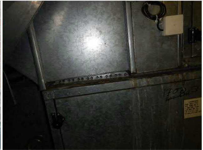
Kuva 110 Ulkoilmasäleikön alapuolinen tiilipinta selvästi kastunut useasti. Myös koneen sisäpuolisissa osissa selviä merkkejä veden pääsystä koneen sisäosiin.
