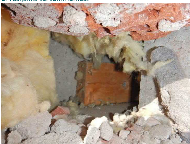
Kuva 67. Rakenneavauksen I6 ikkunan yläpuolinen avaus. Tukipuu on kiinnitetty betoniin naula-ankkurilla.
