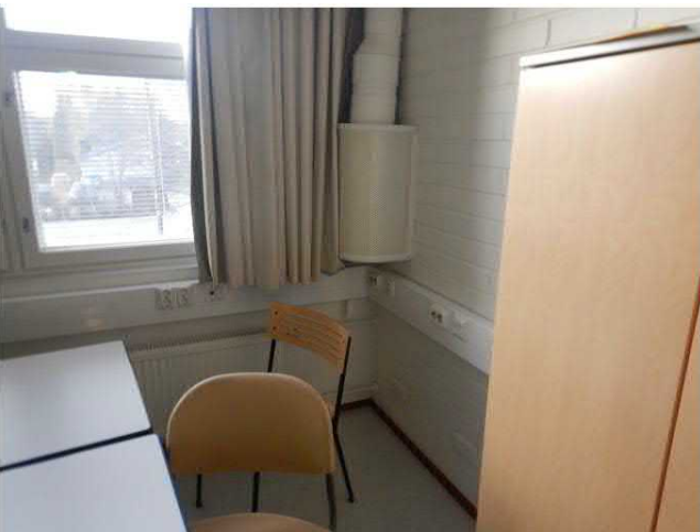
Kuva 100 Laajennusosan tuloilmapäätelaitteina käytetty kattohajottajia ja tuloilmakanavia (oik.). Luokassa 205 tuloilmapäätelaitteet piennopeuslaitteita (vas.), joita käytetään syrjäyttävässä ilmanjakotavassa.
