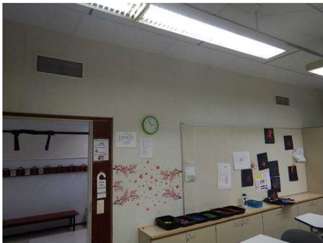
Kuva 101 Alkuperäisen osan ilmanjako on toteutettu tulo- ja poistoilmasäleiköillä. Liikuntasalin poistoilmasäleiköt selkeästi likaantuneet.
