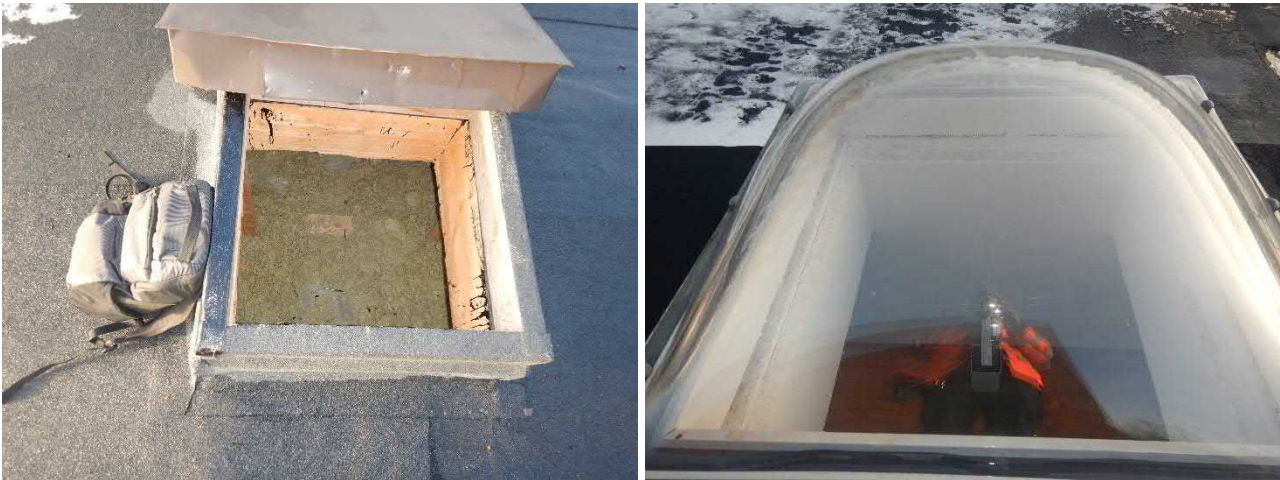
Kuva 88. kupumalliset kattoikkunat ja yläpohjaan johtavat luukut olivat uusittu kattoremontin yhteydessä ja olivat hyvässä kunnossa.
