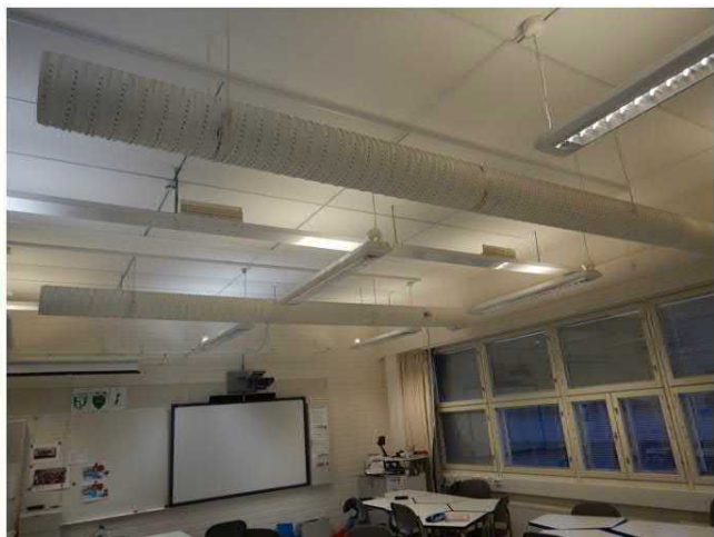
Kuva 100 Laajennusosan tuloilmapäätelaitteina käytetty kattohajottajia ja tuloilmakanavia (oik.). Luokassa 205 tuloilmapäätelaitteet piennopeuslaitteita (vas.), joita käytetään syrjäyttävässä ilmanjakotavassa.
