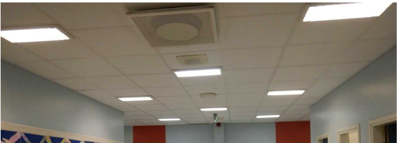
Kuva 94. Laajennusosien alakattojen levypinnat olivat ehjät ja puhtaat.
