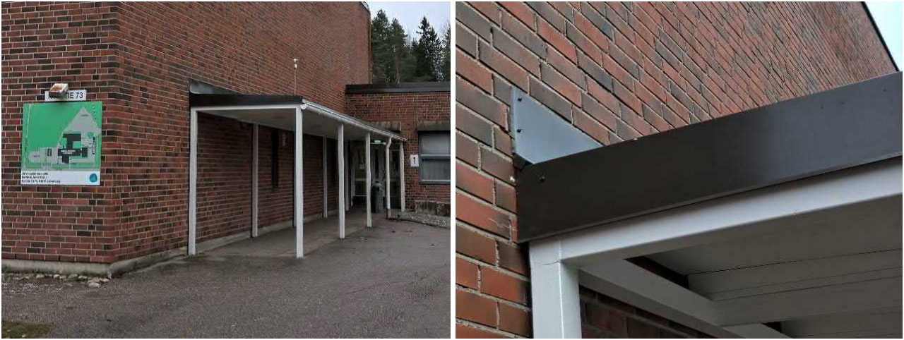
Kuva 72. Rakennuksen sisääntulokatoksen pellitykset on uusittu. Suojapellitys on nostettu ulkoseinärakennetta vasten.
