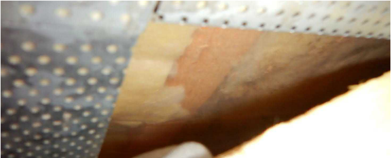
Kuva 84. IV-konehuoneen ulkoseinä- (US5) ja yläpohjarakenteessa (YP3) on yhtenäinen ja ehjä höyrynsulku.
