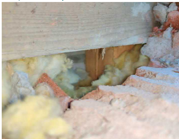
Kuva 62. Rakenneavauksen 17 vaakasuuntainen apukarmi tukeutuu pystysuuntaiseen puuhun (50x100).
