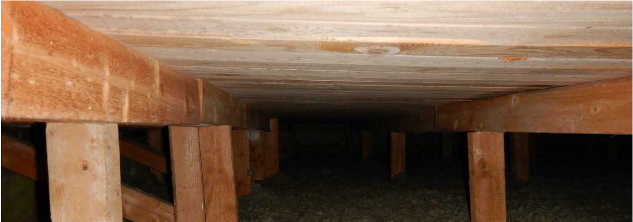
Kuva 82. Yläpohjan vesikaton runkorakenteet olivat hyvässä kunnossa.
